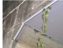
従来工法施工例
